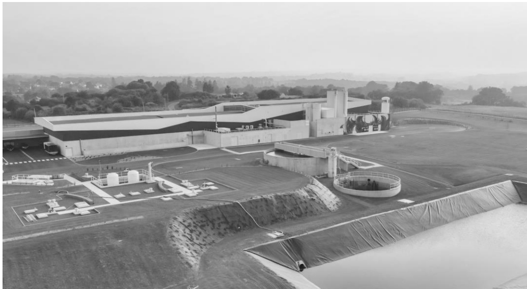
Figure 1 : usine de production d'eau potable de l'agglomération de Saint-Brieuc
