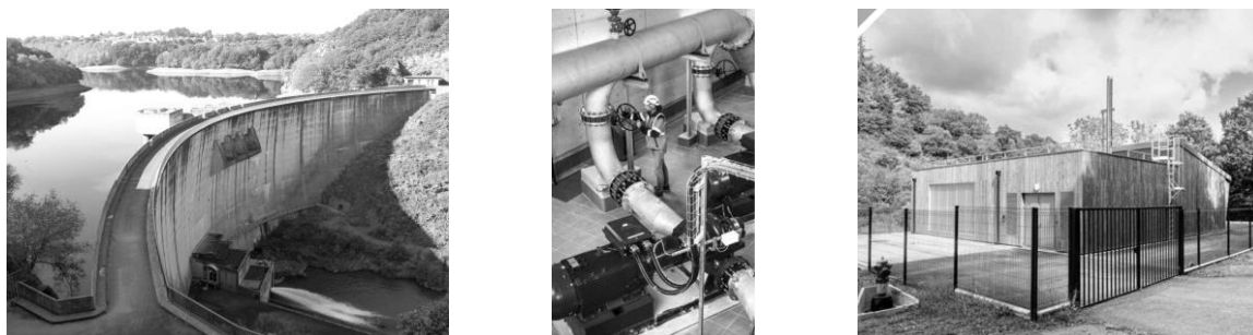
Figure 3 : barrage Saint Barthélémy – station de pompage et son bâtiment d'exploitation
